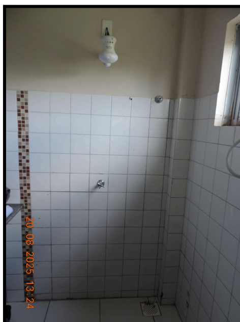
Área do banho no alojamento materno-infantil, com registro do chuveiro. Fonte: MEPET/ES, 2025..
