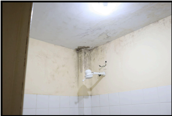
Banheiro do espaço para visitas íntimas: (a) vista frontal com bacia sanitária e pia; (b) área do chuveiro com indícios de possível infiltração. Fonte: MEPET/ES, 2025.
