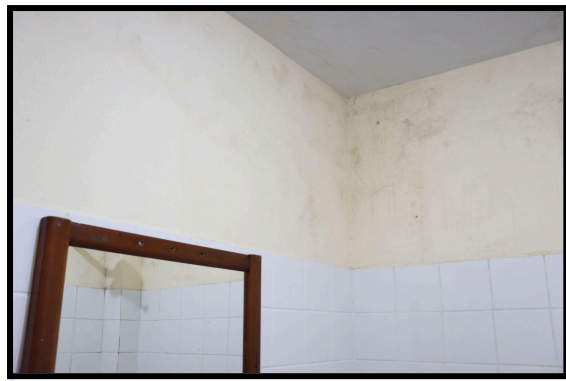
Registros no espaço destinado às visitas íntimas, com indícios de possíveis infiltrações (a) e (b). Fonte: MEPET/ES, 2025.
