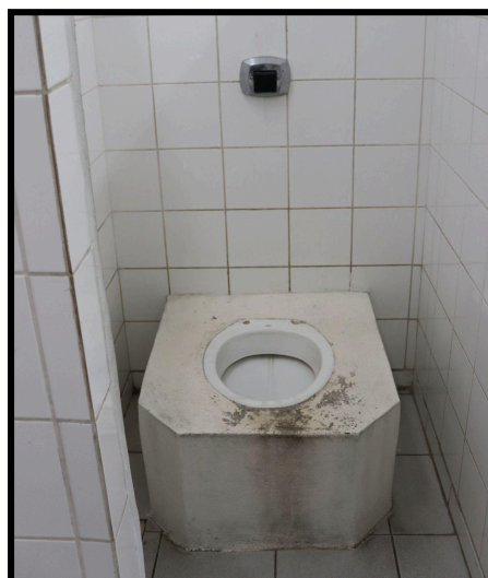
(a) Banheiro com espaço para revista. (b) Bacia sanitária concretada. Fonte: MEPET, 2025.
